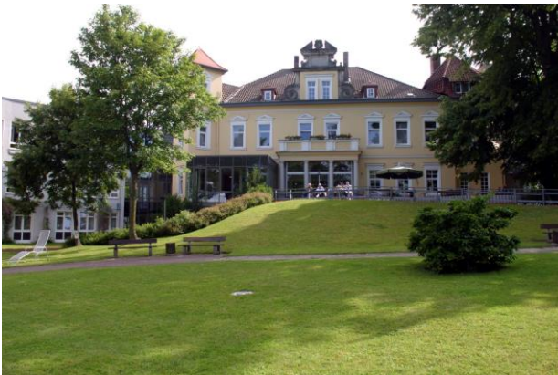
Krankenhaus Lindenbrunn, 31863 Coppenbrügge
