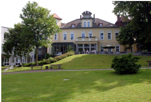
Krankenhaus Lindenbrunn, 31863 Coppenbrügge
